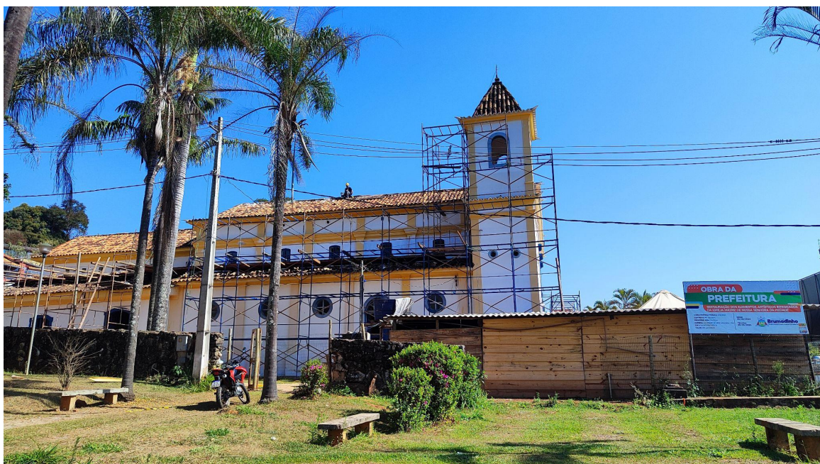
Vista da edificação em obras e a placa de obras da parte da obra custeada pela prefeitura para restauração dos elementos artísticos Autoria: Francielle Ferreira Data: 19/08/2025
