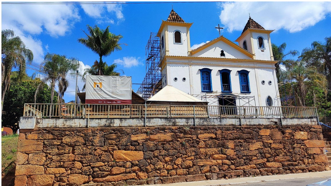
Vista da edificação em obras e a placa de obras da obra em execução via Plataforma Semente - Obra Civil Autoria: Francielle Ferreira Data: 19/08/2025
