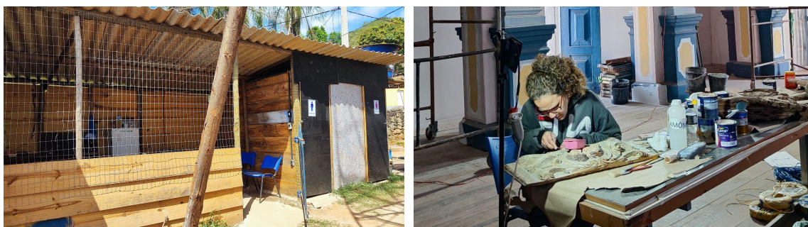
Canteiro de obras externo montado e ateliê de restauro dos elementos artísticos montado na nave Autoria: Francielle Ferreira Data: 19/08/2025
