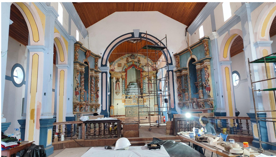
Vista da nave da edificação - ateliê de restauro dos elementos artísticos e obra civil em andamento Autoria: Francielle Ferreira Data: 19/08/2025
