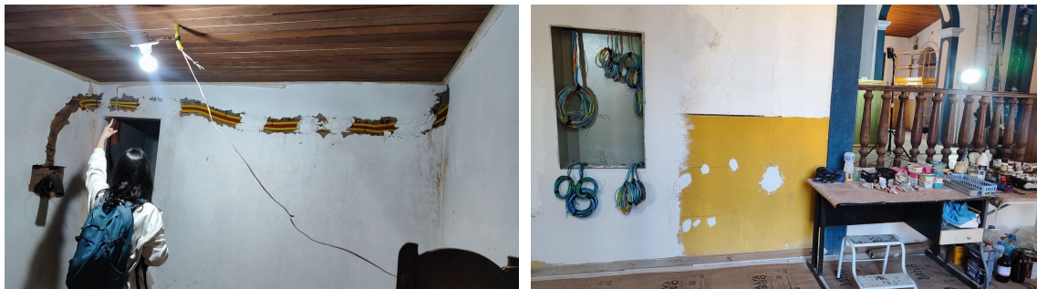
Execução das instalações elétricas em andamento
