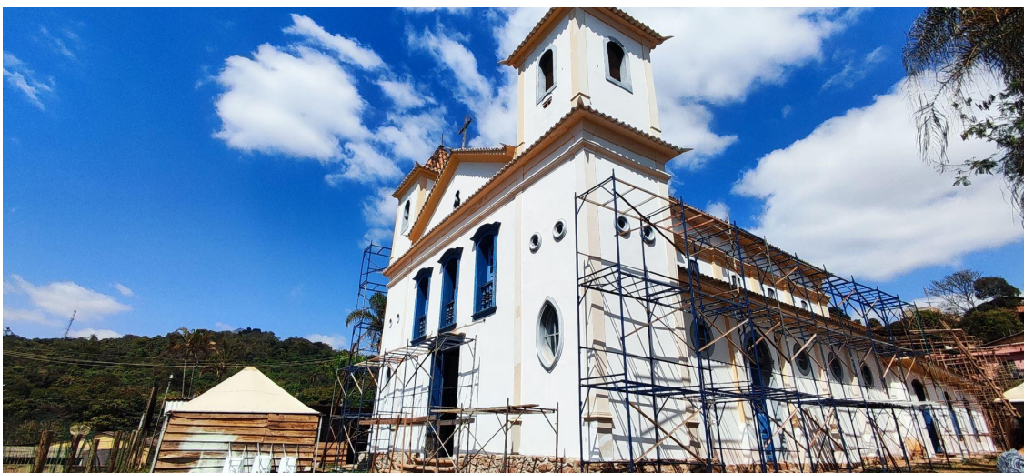
Adro e fachadas externas - montagem de andaimes e preparação da pintura externa
