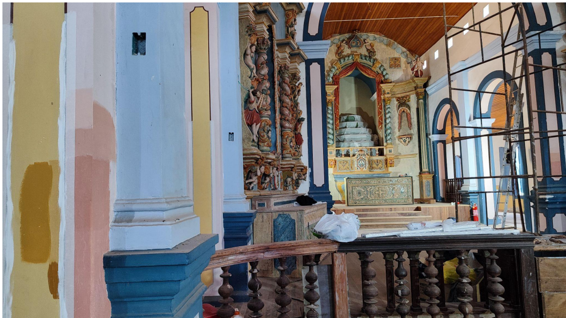
Vista da nave da edificação - realização de testes pictóricos nas alvenarias Autoria: Francielle Ferreira Data: 19/08/2025
