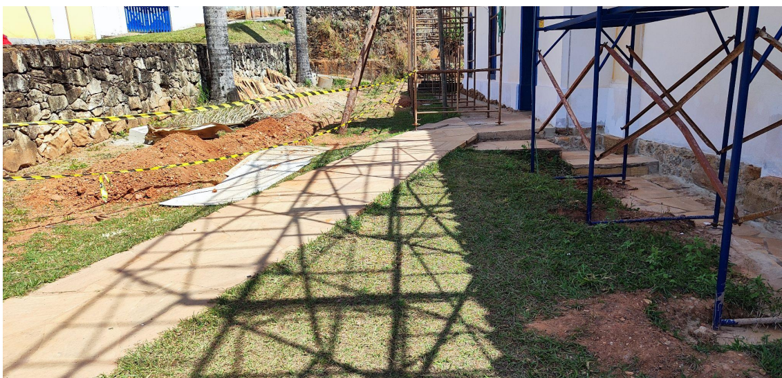
Adro - escavação das valas de aterramento do SPDA
