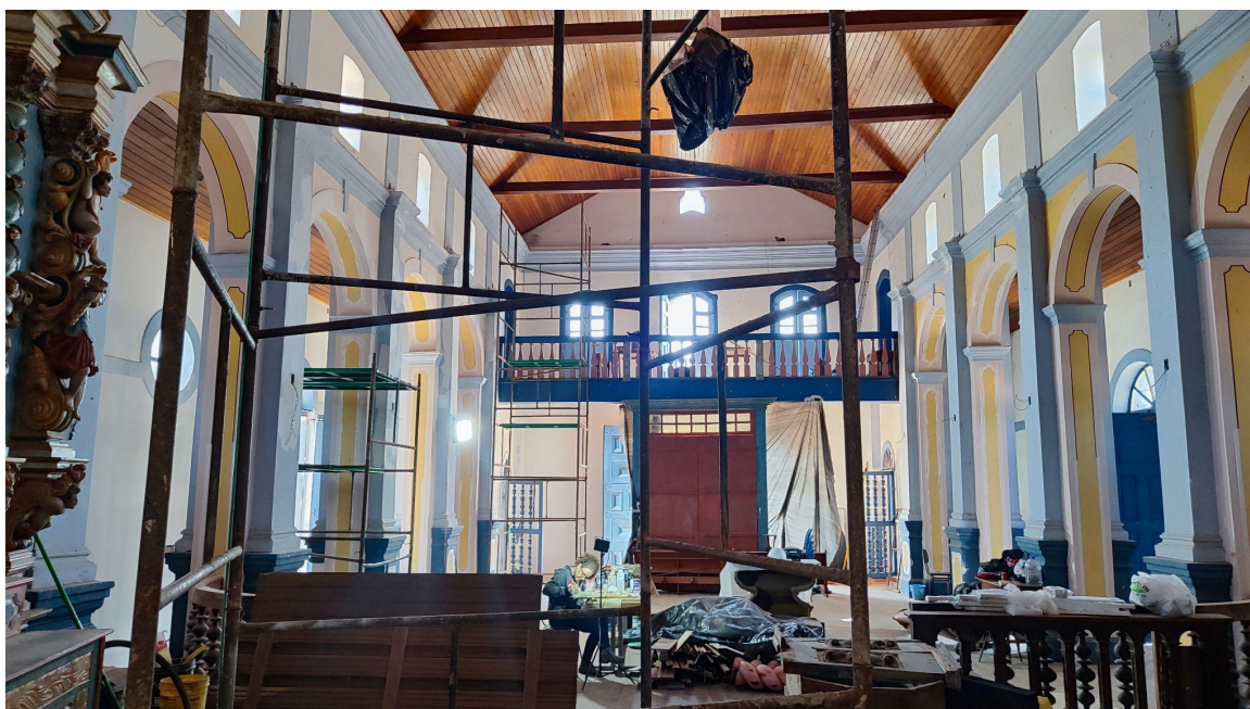
Execução das instalações luminotécnicas em andamento
